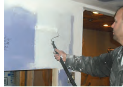
Applying primer to new drywall.
